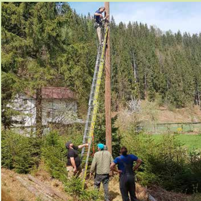
Montaža in napeljevanje dovodnih kablov, april 2020. Na lestvi – Peter Prapertnik, spodaj od leve proti desni Rajko Prapertnik, Peter Skarlovnik st., Matej Hudernik
