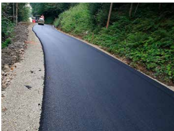
V Robnikovem jarku smo sanirali klanec do mostu
