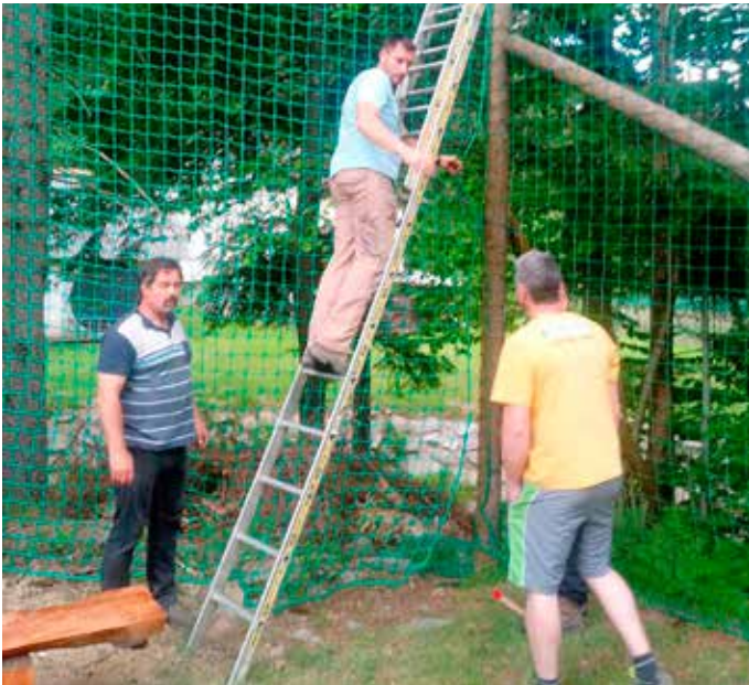
Montaža zaščitne mreže. Od leve proti desni: Založnik Franc, Pušnik Matjaž in Ravnjak Matej
