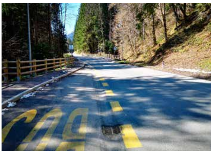
Uspešna rekonstrukcija ceste Ribnica–Podvelka
