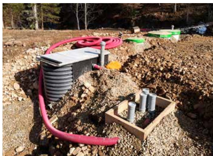
Čistilna naprava v Zgornjem Lehnu v izgradnji
