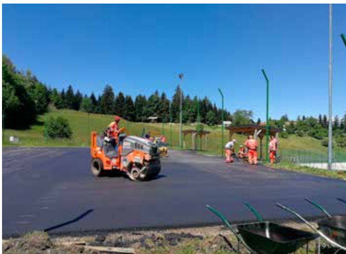
Novi asfalt na igrišču v Josipdolu
