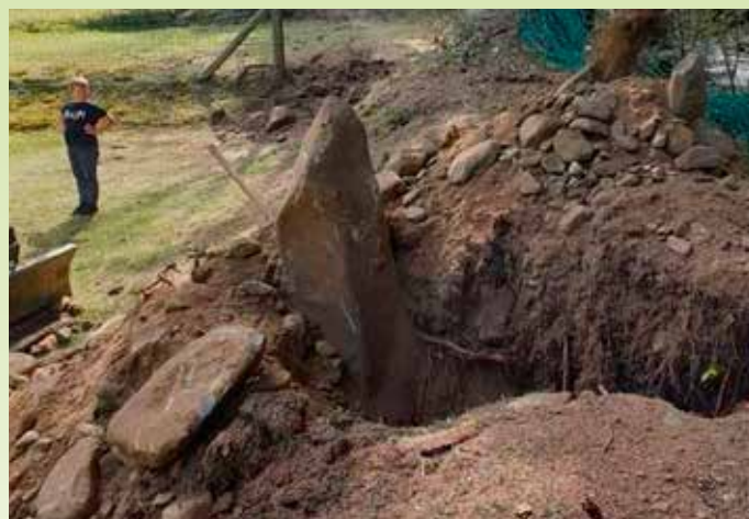
Izkop in postavitve drogov – »še dobro, da ni veliko kamenja« – april 2020
