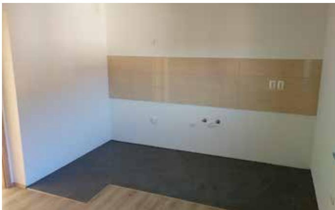
Vsako leto v celoti obnovimo kakšno stanovanje
