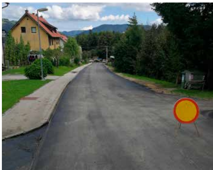
Po zgrajeni kanalizaciji smo preplastili ceste v Josipdolu
