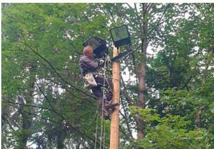
Priklop reflektorjev na višini – Marjan Grosek – april 2020
